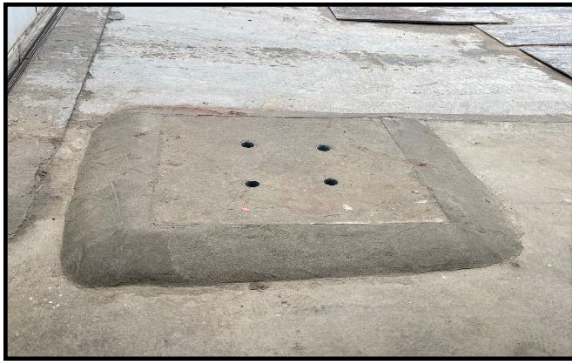
รูปที่ 2-42 ท่อระบายน้ำคอนกรีตเสริมเหล็กชั่วคราว
