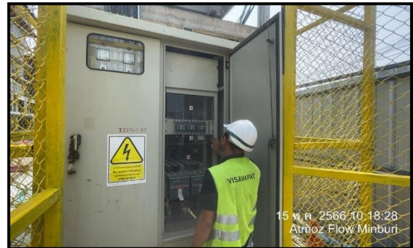
รูปที่ 2-35 ติดตั้งหม้อแปลงไฟฟ้าชั่วคราว
