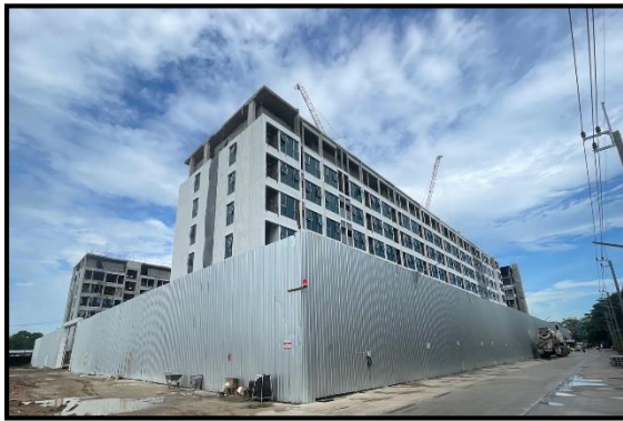
รูปที่ 2-1 จัดทำรั้ว Metal Sheet ความสูง 6 เมตร
