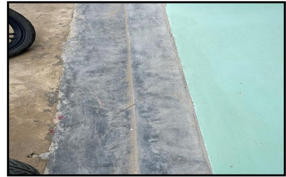
รูปที่ 2-43 รางระบายน้ำคอนกรีต
