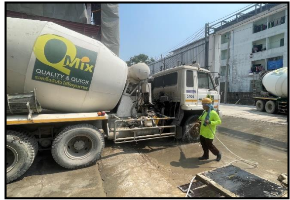
รูปที่ 2-10 พื้นที่ล้างทำความสะอาดล้อรถบรรทุก
