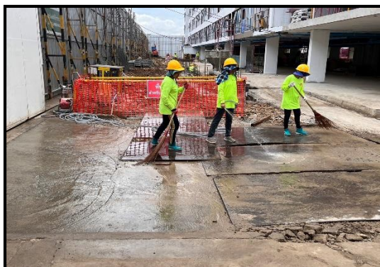
รูปที่ 2-7 กิจกรรมฉีดพรมน้ำบริเวณพื้นที่ก่อสร้าง
