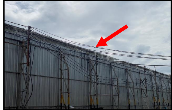
รูปที่ 2-6 ติดตั้งชุดหัวฉีดสเปรย์น้ำละอองฝอย
